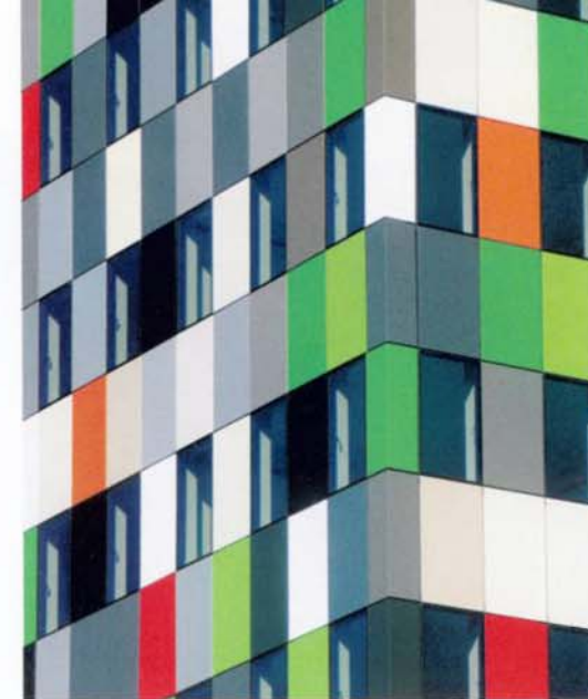
Für eine langfristig farbintensive Ausstrahlung wurden die Aluminiummodule pulverlackiert.
